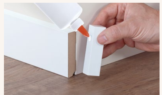
Durch Kleben oder Leimen an den Stirnseiten der Sockelleisten befestigen.
